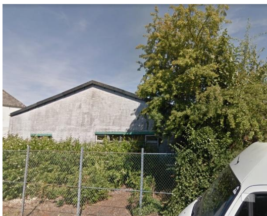
Afbeelding 4. Zuidelijke bedrijfshal met begroeiing ernaast. Er zijn aan de zuidzijde (rechts op de foto) geen invliegmogelijkheden voor vleermuizen.
