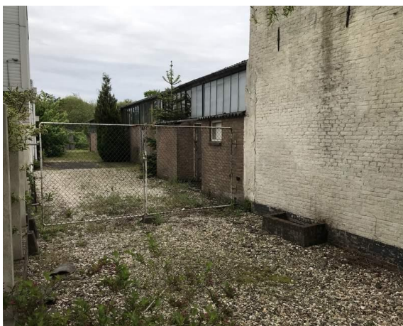
Afbeelding 6. Oprit aan de noordkant van het onderzoeksgebied
