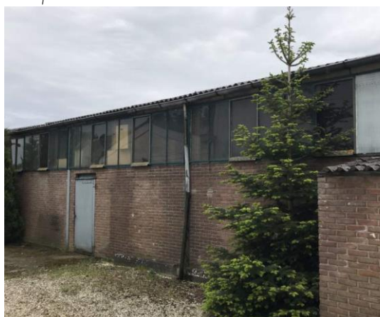
Afbeelding 5. De langgerekte bedrijfshal die direct gekoppeld is aan het woonhuis,
