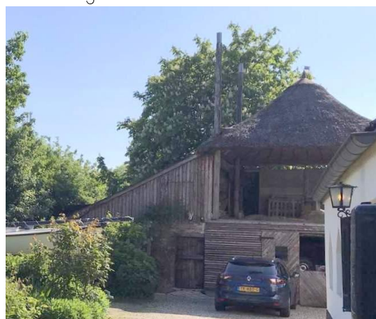
Afbeelding 11. De hooiberg van de naastgelegen woning is geheel open en heeft geen balken in het aangebouwde deel links. Hier is geen roestplaats of nestgelegenheid aanwezig voor kerkuilen vanwege het ontbreken van een balkenlaag.
