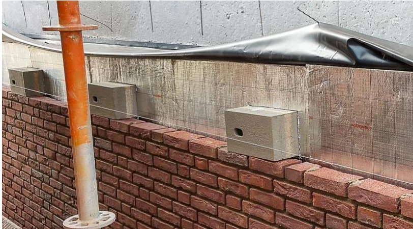
Afbeelding 4 – Inbouwstenen voor gierzwaluwen, tussen twee nesten zit ongeveer een meter ruimte.
