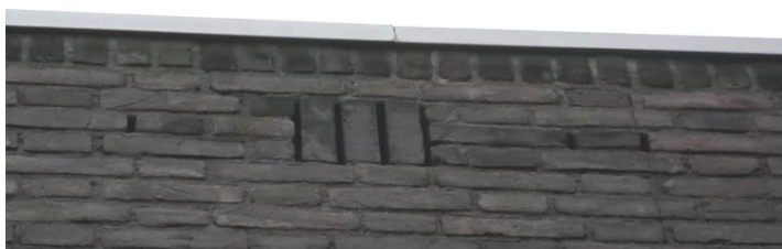
Afbeelding 1 – Voorbeelden van verschillende typen open stootvoegen die kunnen dienen als invliegopening voor vleermuizen. Deze openingen zijn aangebracht voor de ventilatie van de luchtspouw en de ruimte onder het (platte) dak.
