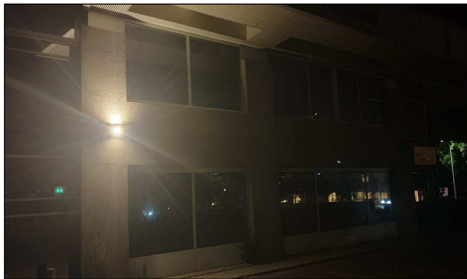
Aan de westkant van het grote gebouw Beursplein is een zeer sterke lamp aanwezig die altijd aanstaat.
