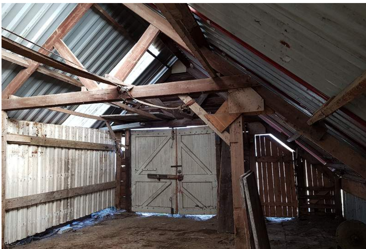
Binnenzijde opstal. Foto: B. Verhoeven | Ecoresult B.V.
