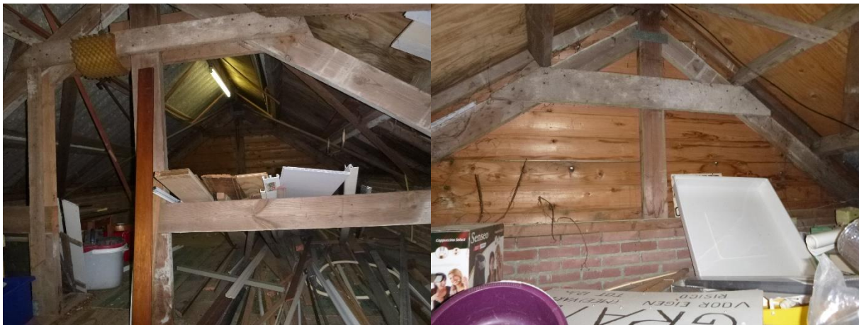
Figuur 3-2. Impressie van de vliering van het te slopen campinggebouw.
