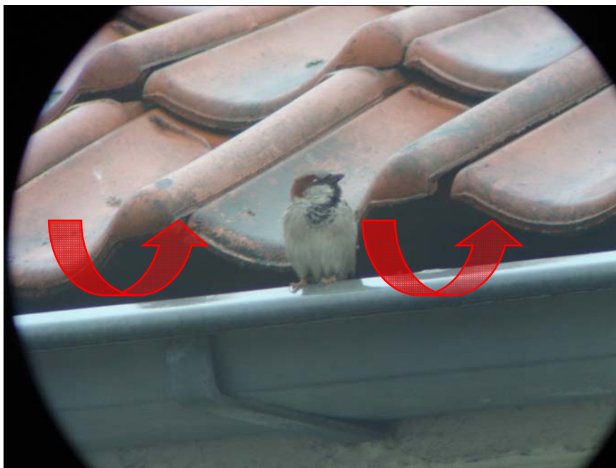
Figuur 3.1. Huisemus in het plangebied waarschijnlijk zittend voor de nestopening (rode pijlen). Door de toegang vanuit de dakgoot onder de eerste pannenrij te versperren kunnen mussen hier niet gaan broeden.
