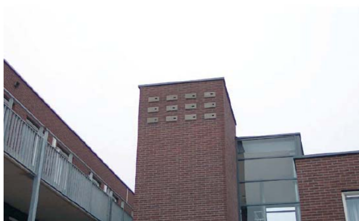
Figuur 3.9. Gierzwaluw neststenen zichtbaar in een liftschacht in Kampen [Actieplan Stadsvogels, Vogelbescherming Nederland, 2006].
