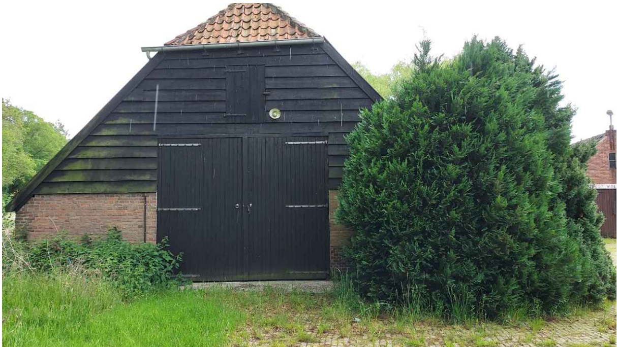
Figuur 9. Gebouw C: stal (te slopen)
