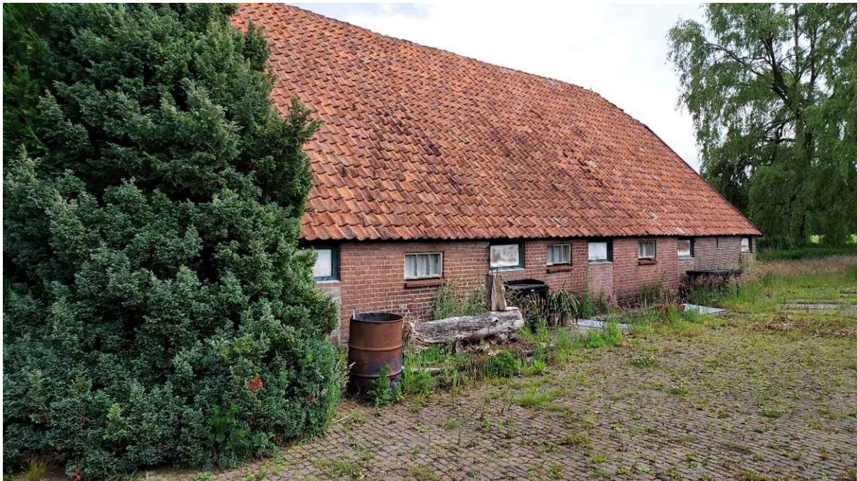
Figuur 8. Gebouw C: stal (te slopen)
