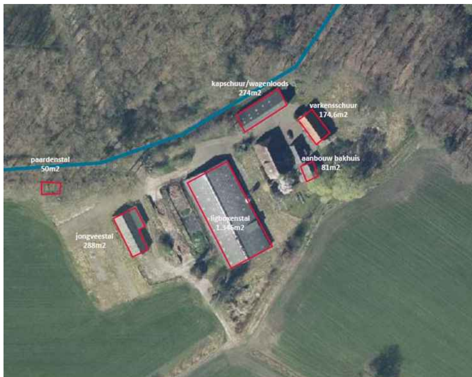
Figuur 5. Roodomrand de te slopen gebouwen en bouwwerken
