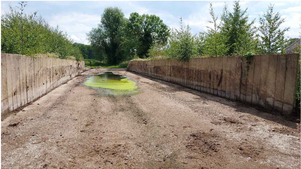
Figuur 12. Bouwwerk F: oostelijke gleufsilo (te verwijderen)
