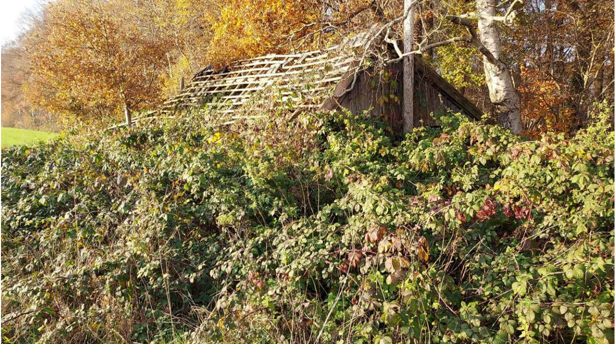
Figuur 16. Gebouw H Paardenstal (te slopen)
