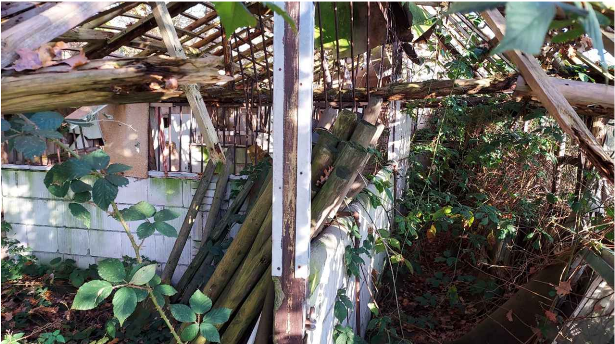
Figuur 17. Gebouw H Paardenstal (te slopen)
