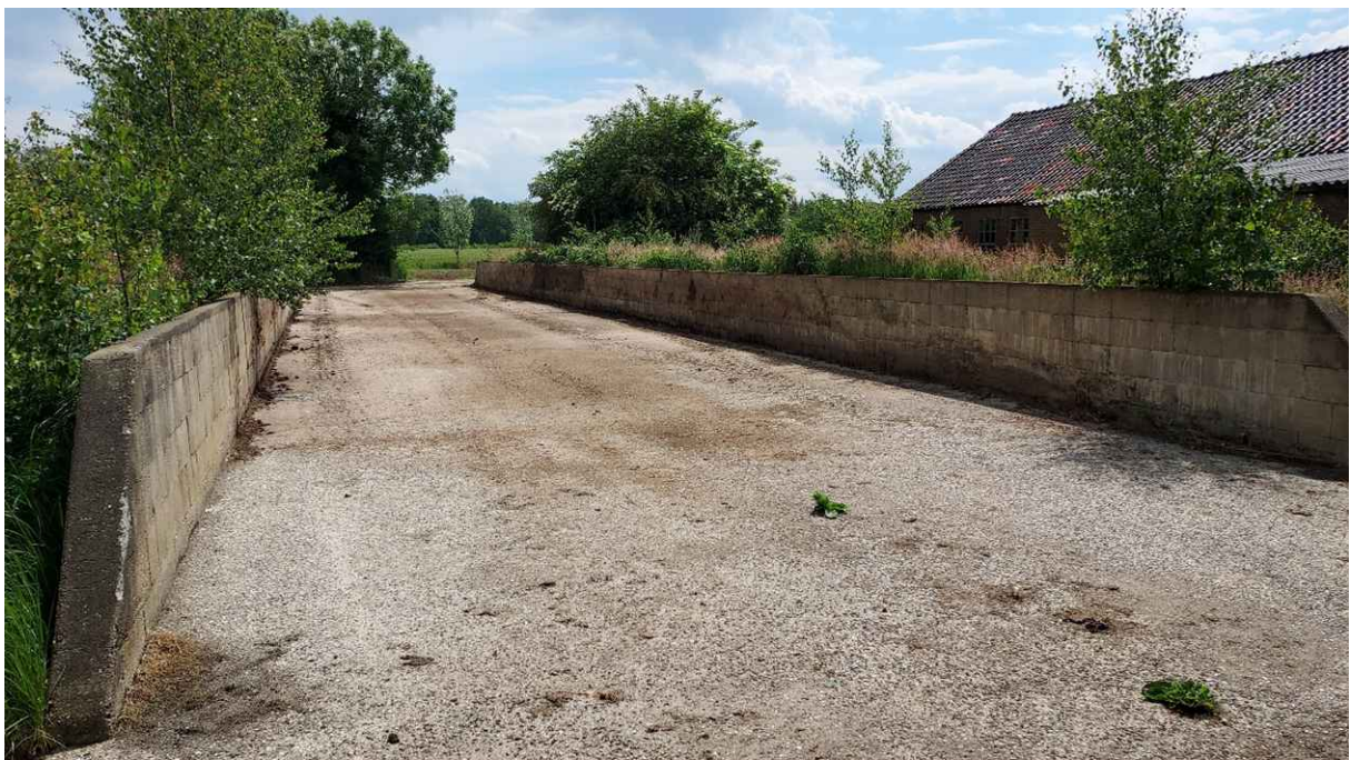
Figuur 13. Bouwwerk F: westelijke gleufsilo (te verwijderen)
