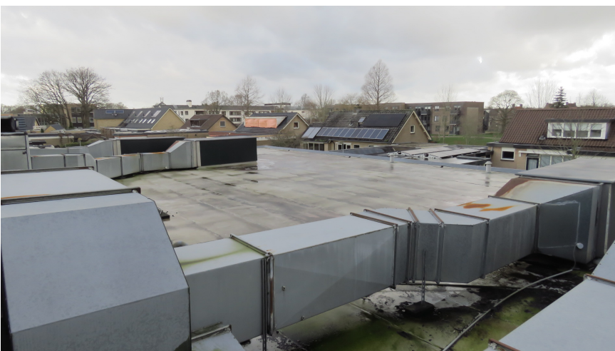
Afbeelding 5: Zicht op het platte dak van het zalencentrum.
