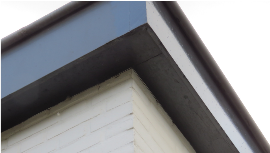
Afbeelding 11: Het houten dakoverstek sluit nauw aan op de gevel van de laagbouw.
