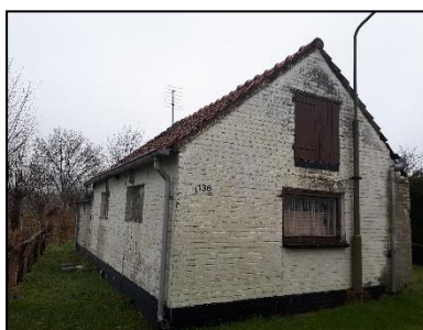
Figuur 7. Te slopen woning aan de Vlieterweg.
