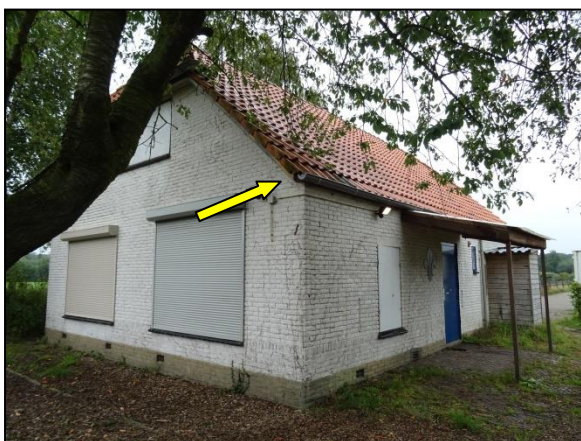
Figuur 9. Ruimte onder de dakpannen.
