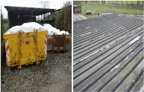
foto 3: Containers, en dak schuur/garage restanten verwijderd.
