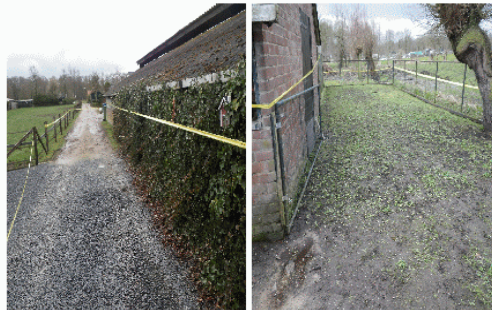
foto 4: Zijkant en achterzijde (restanten verwijderd).
