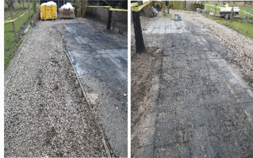
foto 2: Grind en tegels (restanten verwijderd).
