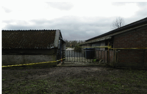
foto 5: Overzicht met schuur van buren.
