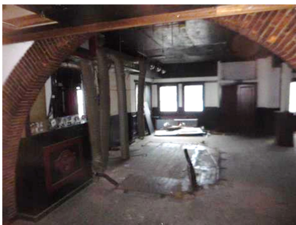
Binnenzijde leegstaand pand
