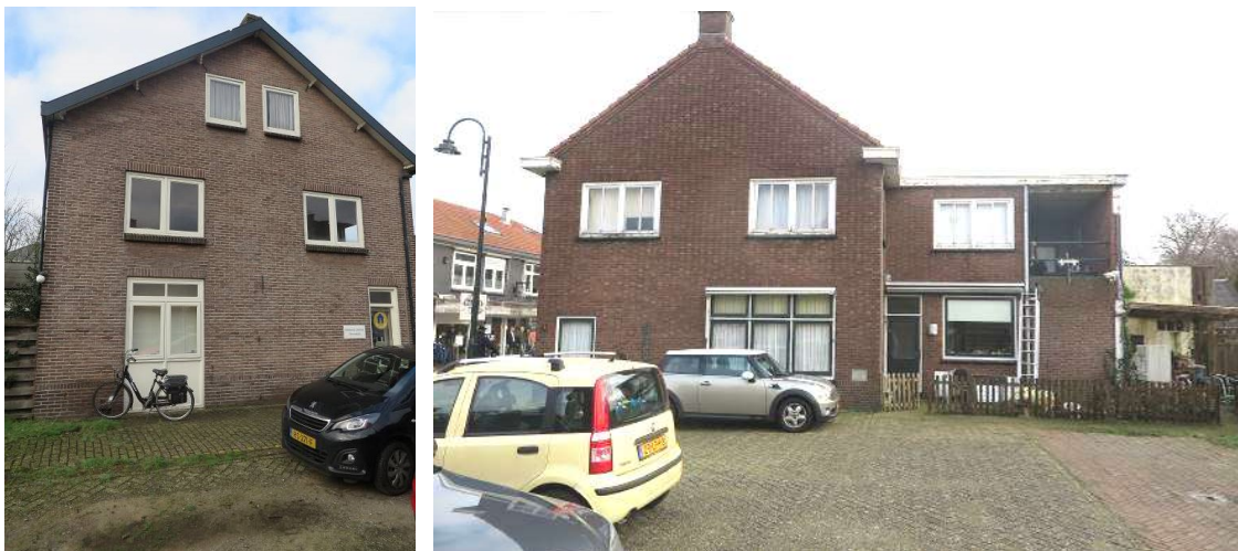
Vervolg figuur 2. Foto-impessie van het plangebied aan de Dorpsstraat 226-234 te Scherpenzeel (woonbebouwing).
