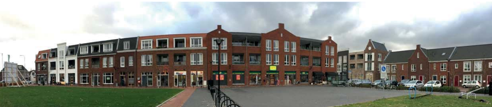
Het vernieuwde dorpscentrum van Renswoude, met onder meer een nieuwe vestiging van Em-Te (817 m 2 wvo)
