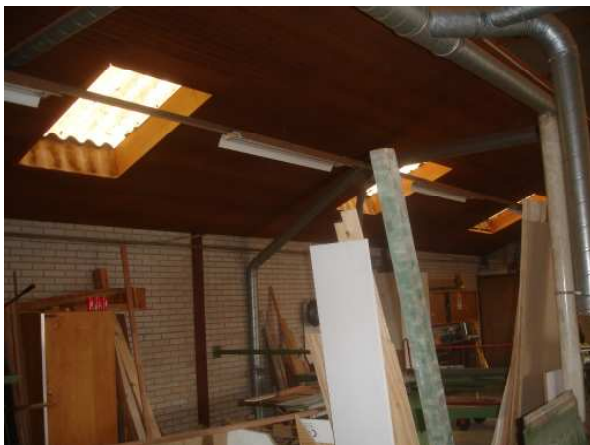
foto 2: drie van de lichtstraten in het geïsoleerde dak
