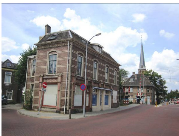
Winkelwoonhuizen aan de Emmastraat (gemeentelijk monument ).
