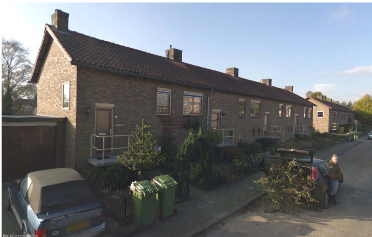
Voorzijde woningen Bronkhorstenstraat 1-15.
