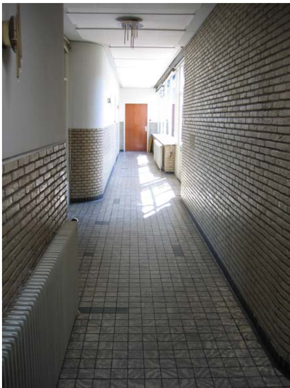
Gangstructuur in de kantoorvleugel
