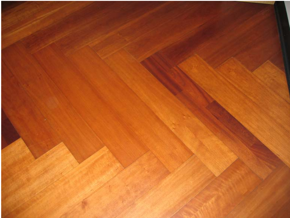
Interieur kantoorvleugel; parketvloer
