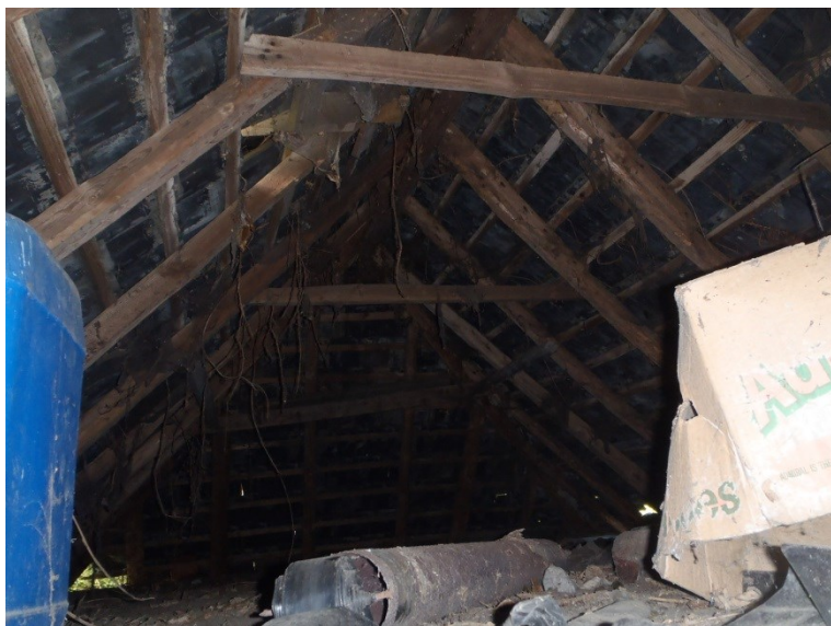
Foto 9, de zolder van de garage. De pannen zijn zichtbaar. De materialen liggen op een enkelvoudige plankenvloer zonder holle ruimte.
