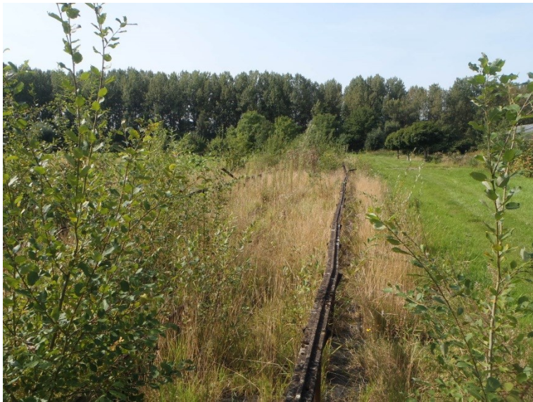
Foto 12 , de voormalige platte bak. De betonnen ligger aan de bovenzijde van de bak is op de foto nog goed zichtbaar. De resterende delen zijn overgroeid.
