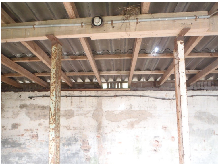
Foto 6 , de binnenkant van de schuur die tegen de tuinmuur is aangebouwd. De muur op de foto is de afgesmeerde tuinmuur. Op een van de balken is een nest van een merel aanwezig.
