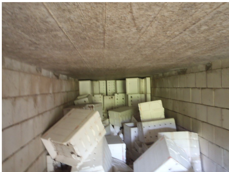
Foto 11, het interieur van de ondergrondse opslag. De gemetselde muren en het betonnen dak zijn goed zichtbaar evenals de grot hoeveelheid polystyreen dozen.
