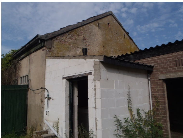
Foto 3: het hoge gebouw is de oude loods met op de voorgrond het aangebouwde toilet. Rechts op de foto is de schuur te zien die tegen de oude tuinmuur is aangebouwd. In de nok van de loods is het gat voor de kerkuil zichtbaar.
