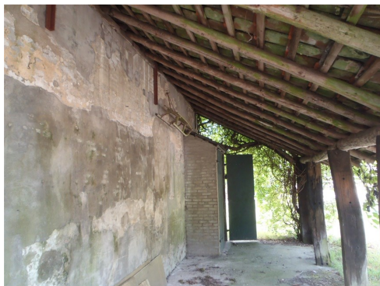
Foto 5: de uitbouw van de loods aan de noordzijde. Op de foto is de aangebouwde pompkast zichtbaar. De niet beschoten dak constructie is goed zichtbaar.
