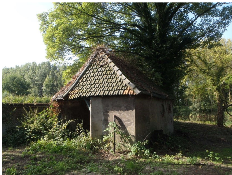
Foto 8 , de oude garage met een pannendak met daarachter en oude vervallen tuinmuur.
