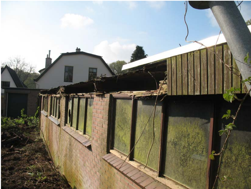
Foto 5: te slopen gevel van de schuur
