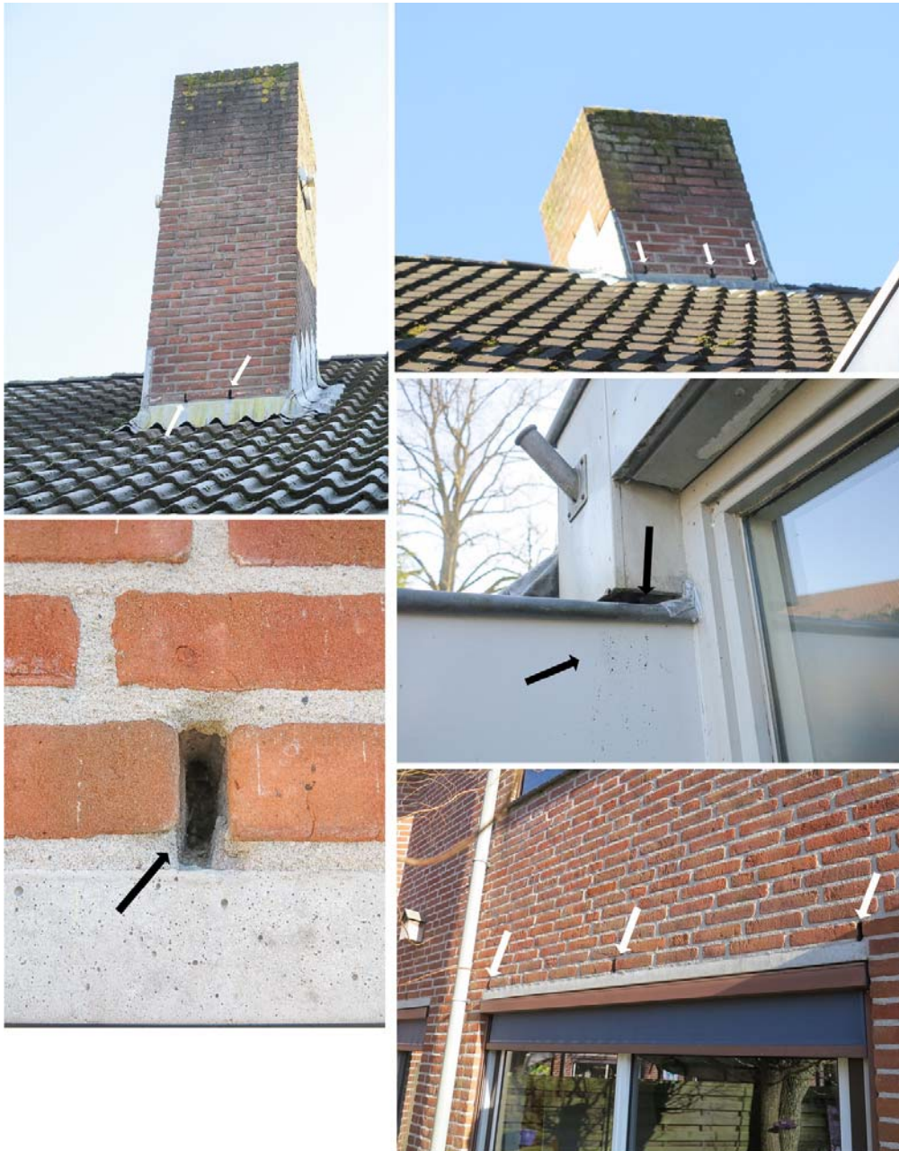
Figuur 3. In- en uitvliegmogelijkheden (stootvoegen en opening naar een van de dakboeien; en sporenaanwijzing) voor vleermuizen in Huize Johanna.
