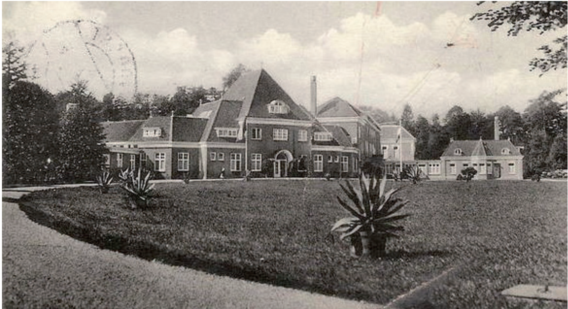
Figuur 11. Het badhuis Laag Soeren op een oude ansicht.
