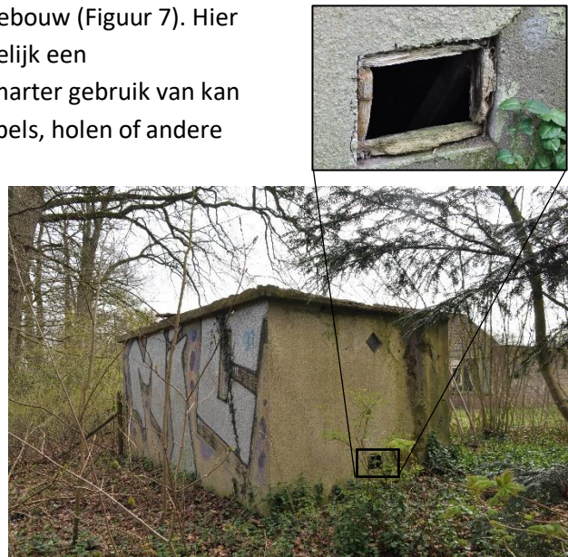
Figuur 7. Het gebouw in de bosschage aan de Parallelweg.
