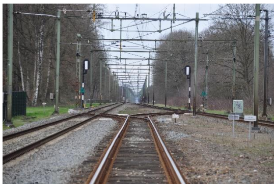
Het spoor bij station Wolfheze
