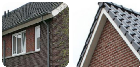
dakoverstek / verbijzondering in de gevel
