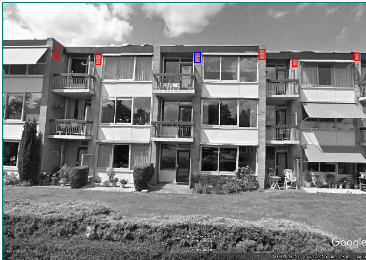
Foto 1. Voorbeeld aan te brengen gaten in buitenmuur om tocht in de spouw te creëren. Het vlak met blauw kader betreft de aangetroffen verblijfslocatie.
