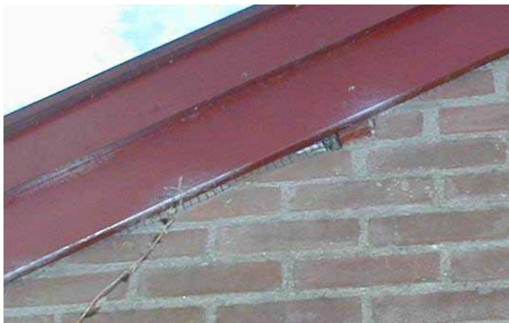
Afbeelding 7: met gaas zijn eventuele invliegopeningen afgedicht. Vaste rust- en verblijfplaatsen van gebouwbewonende soorten vleermuizen zijn niet aanwezig.
