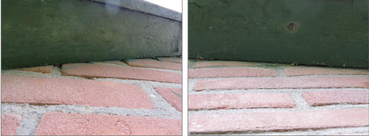
Afbeelding 5.1: Voorbeelden van een nauw aansluitende daklijst. Er is geen mogelijkheid voor vleermuizen om hierachter weg te kruipen. Foto's Natuurkompas, 2017.
