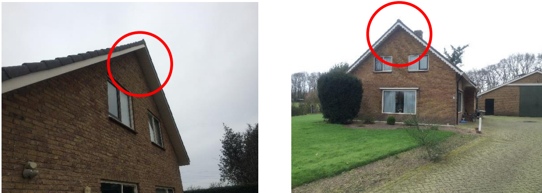
Foto 7 & 8 woning met kleine openingen tussen gevel en dakoverstek
