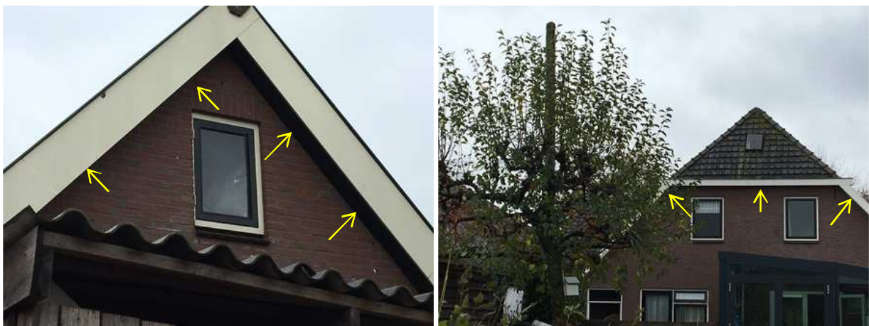
Potentiële invliegopeningen die vleermuizen in staat stellen een verblijfplaats in de spouw te bezetten.
