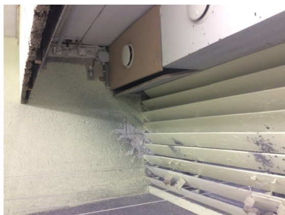
Figuur 3: Kogelvanger achterin baan met afzuiging
