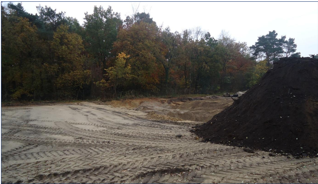
Figuur 15: Saneringswerkzaamheden binnen het onderzoeksgebied. Op deze locatie is de bebouwing reeds verwijderd en hebben graafwerkzaamheden plaatsgevonden.
