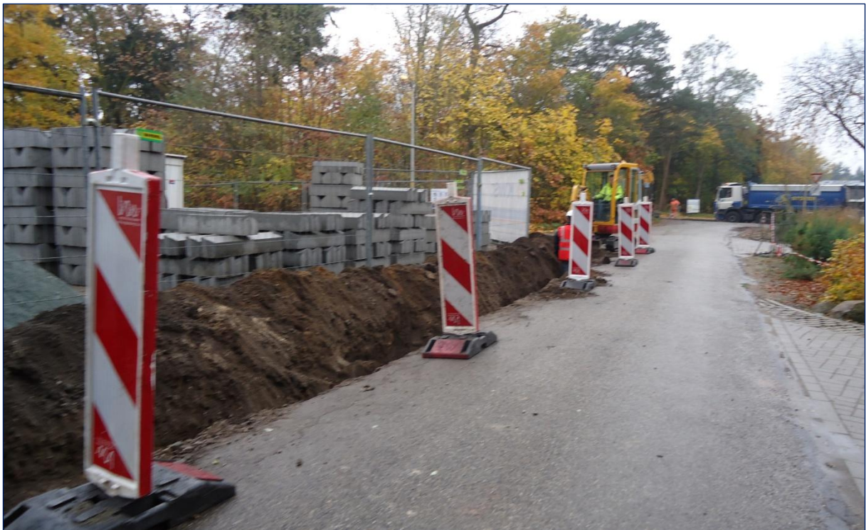
Figuur 16: Binnen het onderzoeksgebied wordt langs de hoofdweg een sleuf gegraven.
