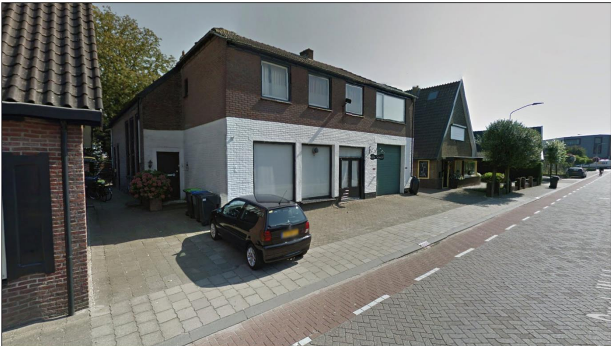
Afbeelding 2.3 Straatbeeld van de bestaande twee-onder-één-kapwoning aan de Grootte Woldweg 12-14 (Bron: Google streetview, september 2016)
