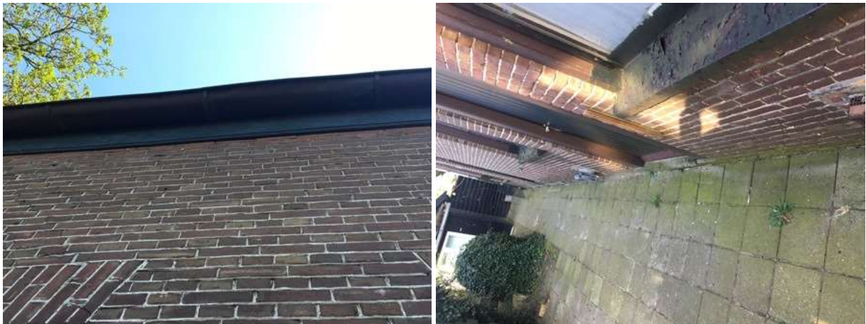
Foto links: een gevelbetimmering met een holle ruimte tussen de buitengevel en de houten betimmering. De holle ruimte lijkt geschikt als verblijfplaats voor vleermuizen, maar onder de 'potentiële hangplek' (foto: rechts) zijn geen verse of oude sporen gevonden, zoals uitwerpselen, die op het gebruik van deze plek door vleermuizen duiden. Omdat onder de 'potentiële hangplek' verharding aanwezig is, zouden eventuele uitwerpselen duidelijk zichtbaar zijn geweest.
