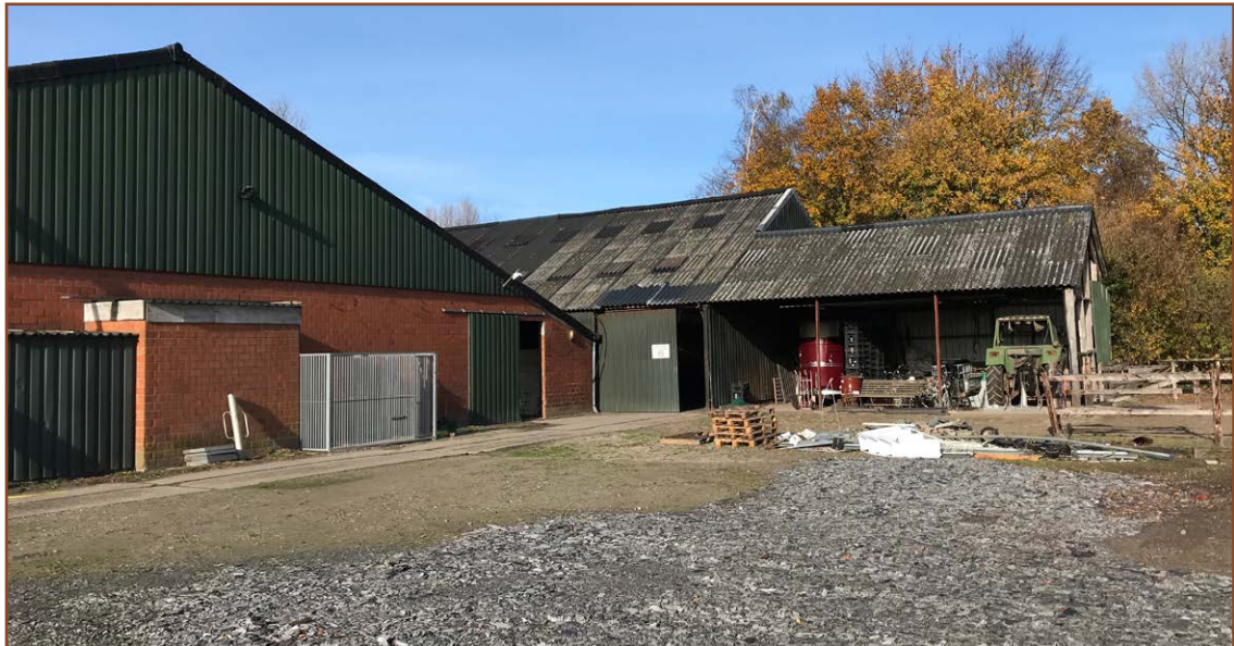
Afb. 2.1: De te slopen manege (links) en de te slopen kapschuur (rechts). Beide gebouwen zijn ongeschikt voor vleermuizen. De gebouwen zijn in potentie wél geschikt voor huismussen.
