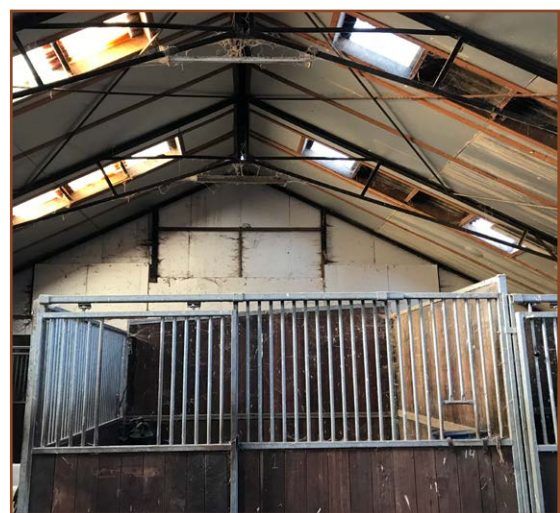
Afb. 2.5: De paardenstal achter de manege bestaat uit open platen met een open nok. Alle gebouwen zijn te open voor de vleermuizen; dit betekent dat de locaties niet geschikt zijn als verblijfplaatsen en nader onderzoek niet nodig is.
