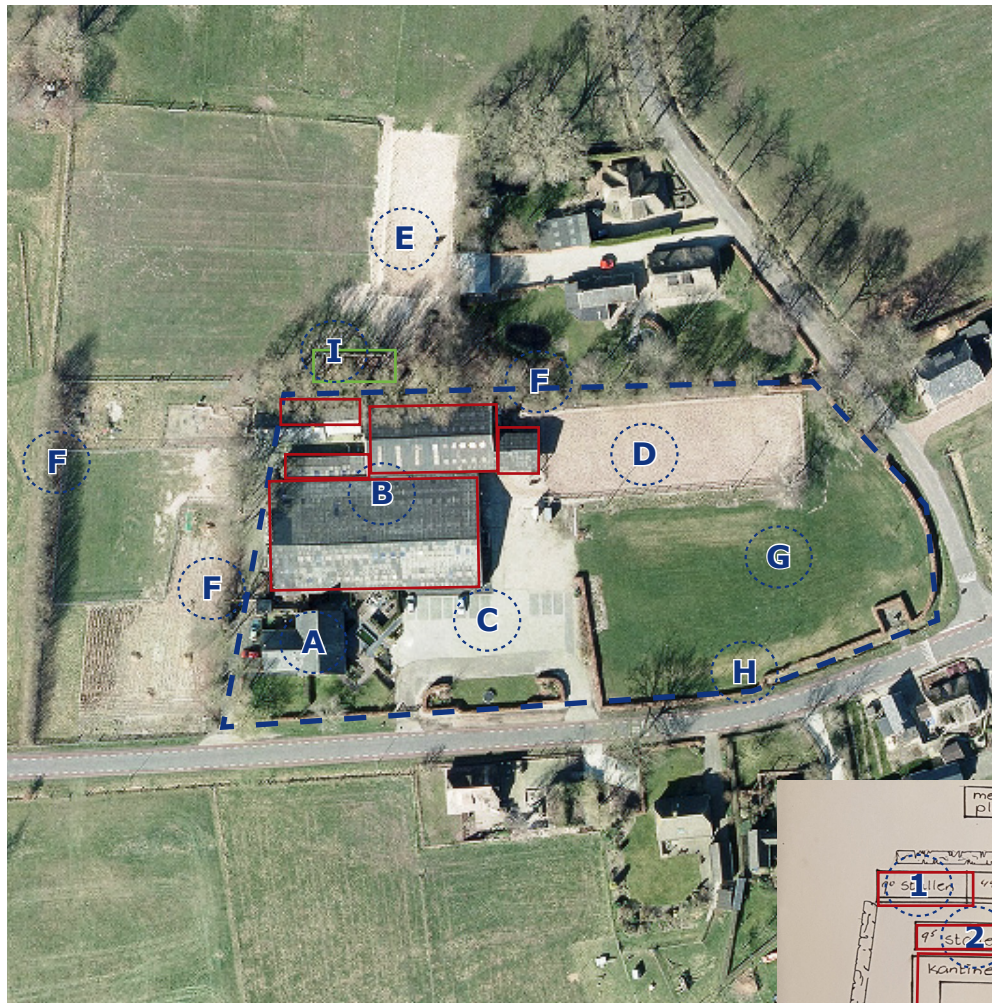
Luchtfoto huidige situatie.
