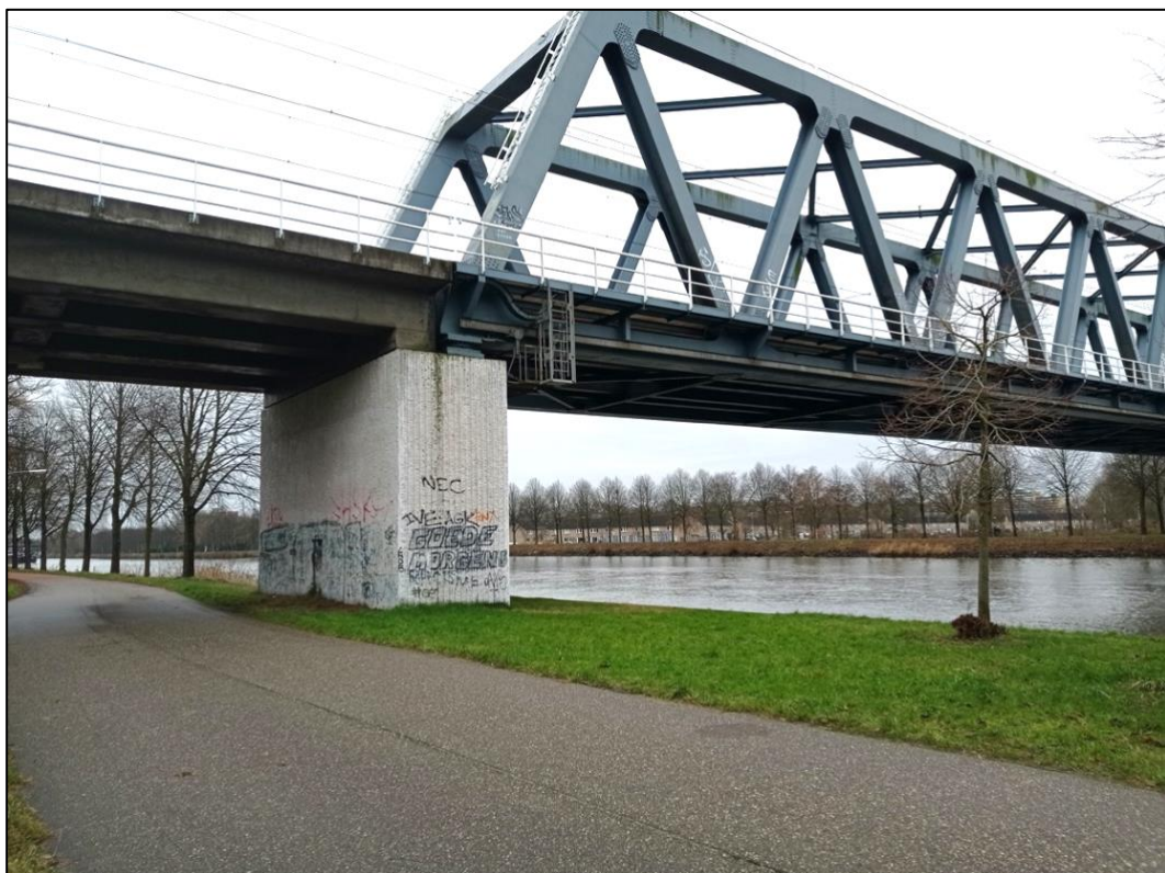
Figuur 10. Graafsebrug over Maas-Waalkanaal.
