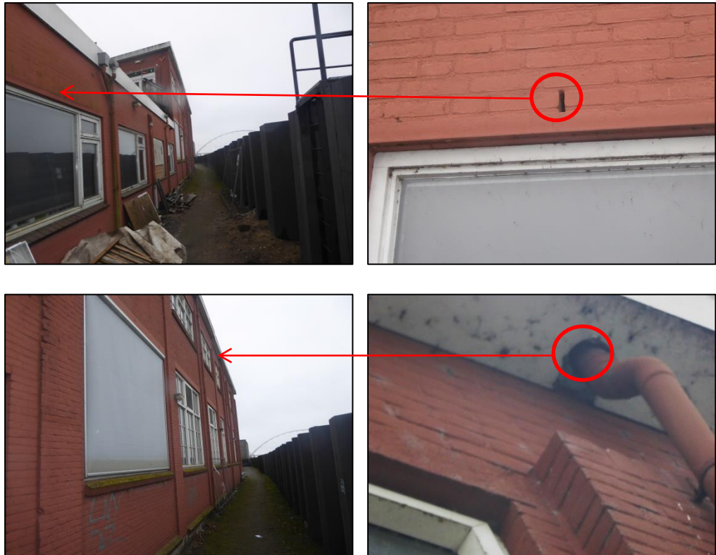
Impressie van het Brebbel gebouw waarin de voor vleermuizen geschikte openingen (met rode pijlen) zijn aangegeven.
