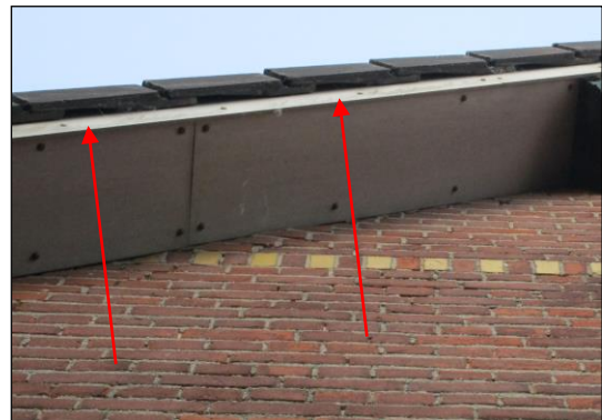
Foto 8: Ruimtes tussen de dakpannen geschikt voor vleermuizen
