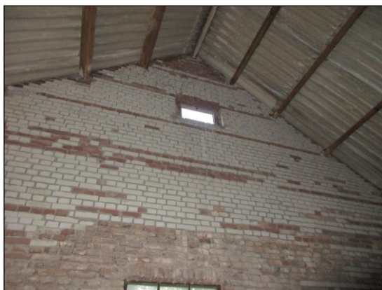
Foto 5: Open raam in open kapschuur aangrenzend aan de woning
