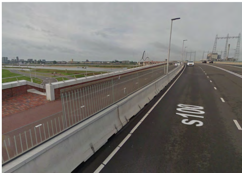
Het bestaande scherm op de Oversteek
