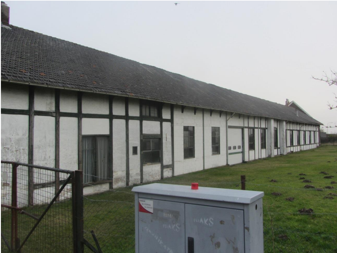
Vooranzicht voormalige machinefabriek aan de Ooyse Sluisweg te Nijmegen
