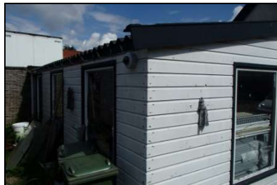
Figuur 4. Houten aanbouw.
