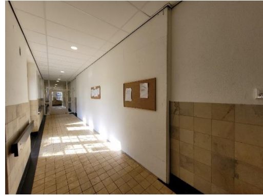
De omstreeks 2015 aangebrachte houten scheidingswand tussen de ingangshal en de gang.
