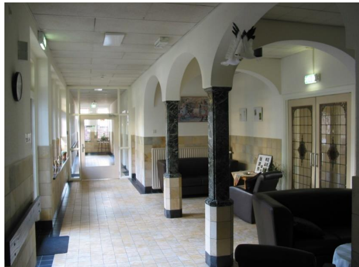
Op deze foto van vóór 2015 stond de ingangshal nog in directe verbinding met de gang van de hoofdvleugel (bron foto: Abken-architecten).
