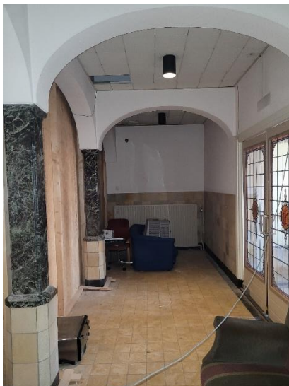
De met een houten scheidingwand afgescheiden ingangshal. De hal heeft een boogstelling op pijlers en originele tegelvloer en lambrisering.
