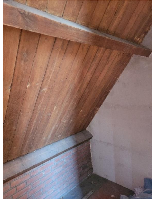
Links: spantbeen met kreupele stijl, met elkaar verbonden door pen- en gat verbinding en metalen strop.
