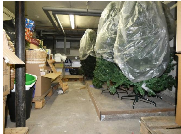
Links: originele stookvloer (1938) en rechts: stookvloer uit omstreeks 1970 met dichtgezet keldervenster op de achtergrond.
