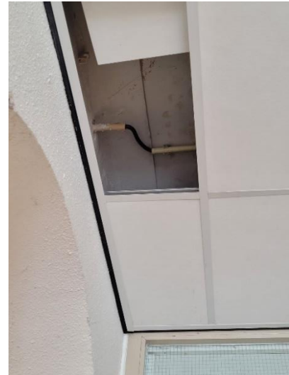
Oorspronkelijk stucplafond achter het moderne systeemplatenplafond.
