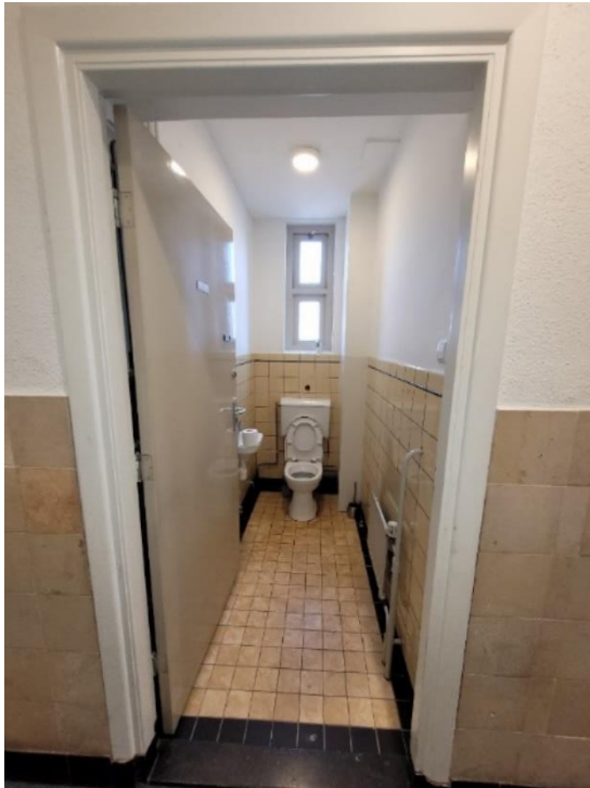
Toiletruimte (ruimte 1.4) met originele tegelvloer en lambrisering. Het bovenraam van het toiletvenster betreft een kiepraam met origineel hang- en sluitwerk.
