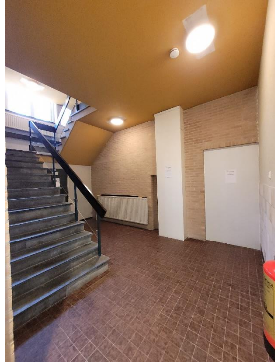
Het trappenhuis uit 1972/1973. Aan de zijde van de binnenplaats is onder het tussenbordse, een ondiep vertrek afgescheiden.
