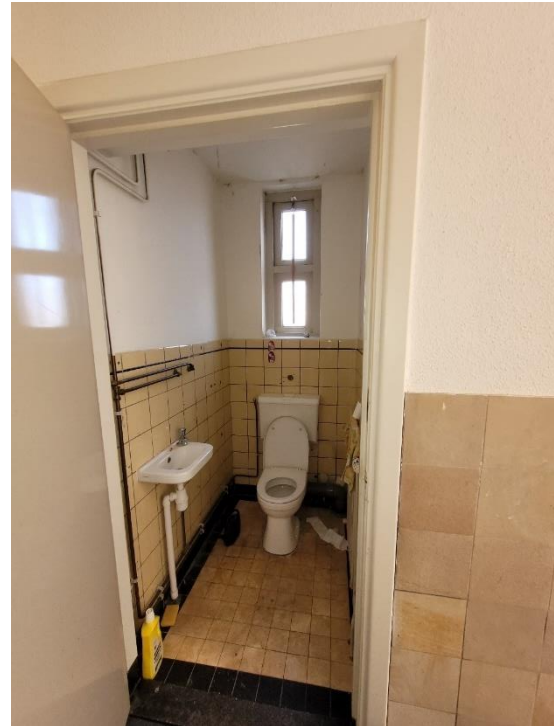
Toiletruimte (ruimte 1.6) met originele tegelvloer en lambrisering. Het bovenraam van het toiletvenster betreft een kiepraam met origineel hang- en sluitwerk.
