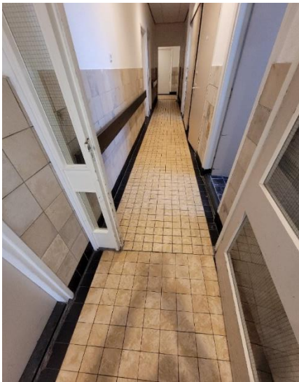
Tegelvloer met kleiner formaat tegels ter hoogte van de sanitair ruimtes.
