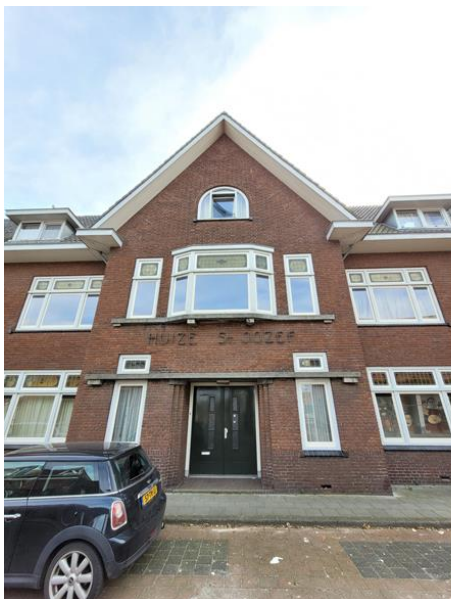
Links: de middenrisaliet met ingangspartij en daarboven de naam 'Huize St. Jozef'. Het kozijn van de dubbele deur is voorzien van natuurstenen neuten met frijnslag en een natuurstenen onderdorpel.
