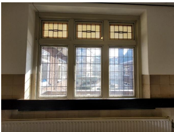
Driedelig venster met glas-in-lood ramen en zwarte natuurstenen vensterbank met afgeronde hoeken links van de balkondeur.
