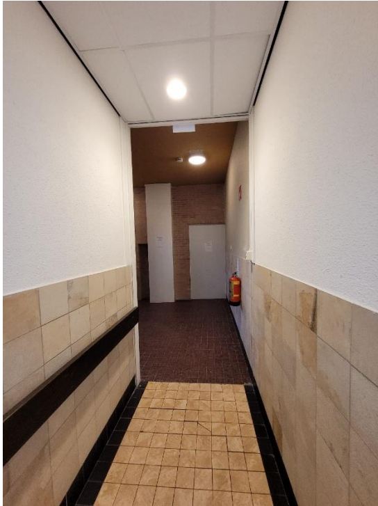
De verbinding tussen de gang en het trappenhuis uit 1972/1973. De doorgang op de achtergrond voerde naar de aanbouw uit 1938 en werd rond 2015 dichtgezet.
