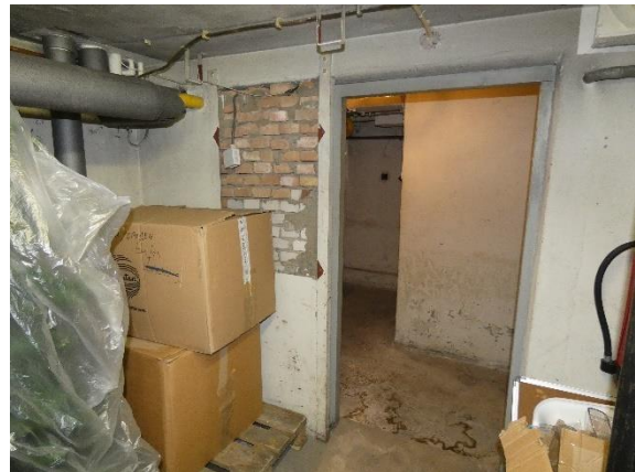
Links: enkele losse bewaard gebleven originele grijze vierpaneelseuren met oorspronkelijke deurklink en rechts: deels dichtgemetselde doorgang van ruimte -0.5.
