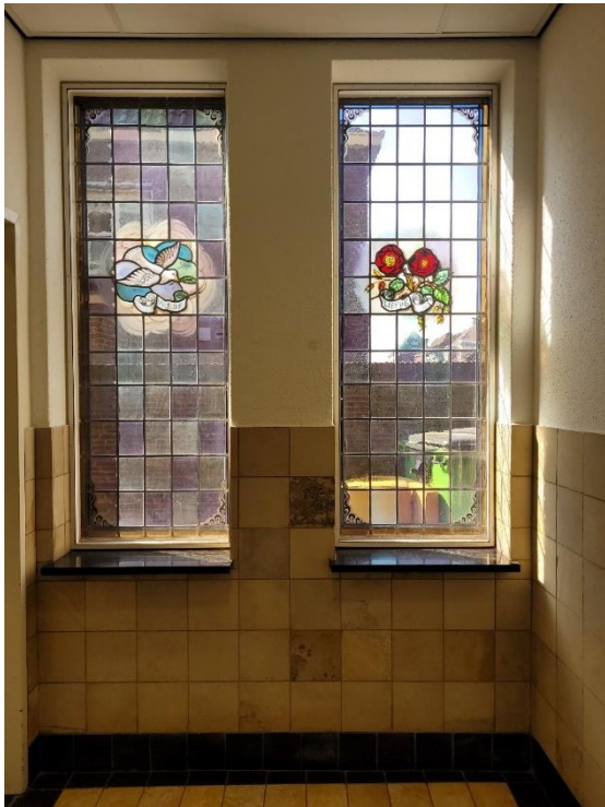
Op de plaats van de oorspronkelijke doorgang omstreeks 1970 aangebrachte hoge staande vensters met glas-in-lood en gebrandschilderde symbolen 'liefde' en 'vrede'.
