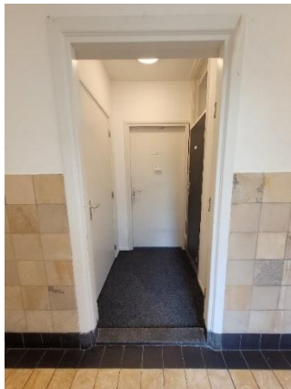
Oorspronkelijke doorgang van vroegere slaapkamer aan de voorzijde. De deur op de achtergrond geeft toegang tot het huidige vertrek 0.17.
