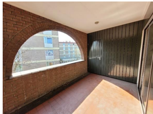
De ondieper gemaakte loggia (ruimte 2.5) met moderne schuifpui en houten berghok aan weerszijden. De loggia is gedekt met een rode tegelvloer met zwarte tegelrand (1972/1973).
