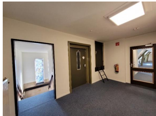
De hal (ruimte 2.1) met doorkijkje via de gewijzigde doorgang naar het tussenbordes met hoge staande glas-in-lood ramen.
