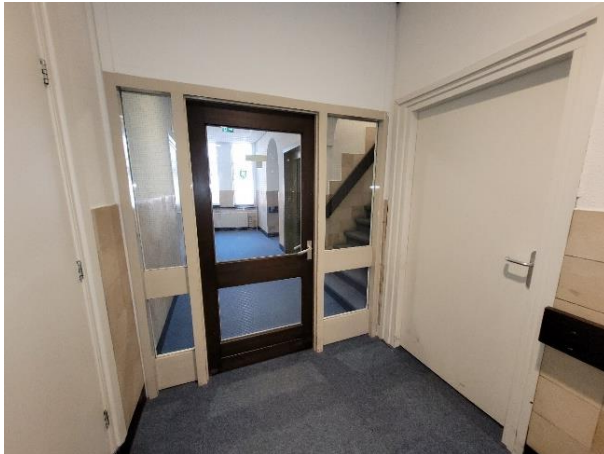
Vernieuwd deurkozijn met branddeur naar de linker zijvleugel, gezien richting de hal met trappenhuis (ruimte 1.1).
