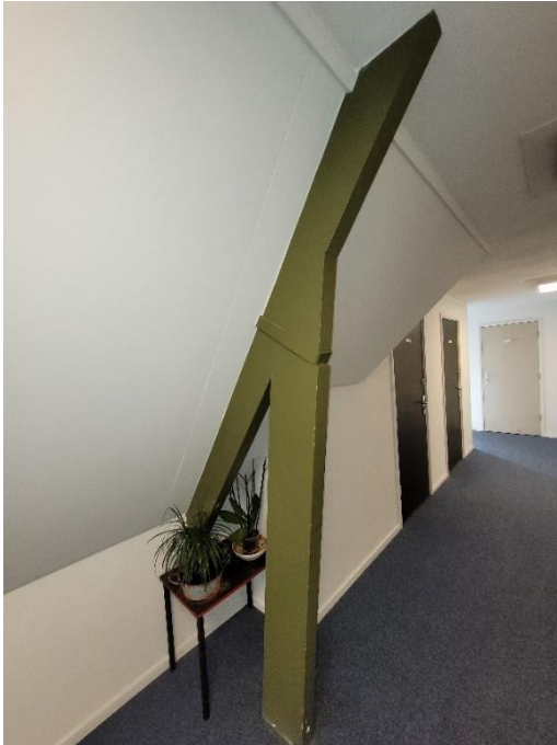
Links: spantbeen met kreupele stijl, met elkaar verbonden door pen- en gat verbinding en metalen strop.
