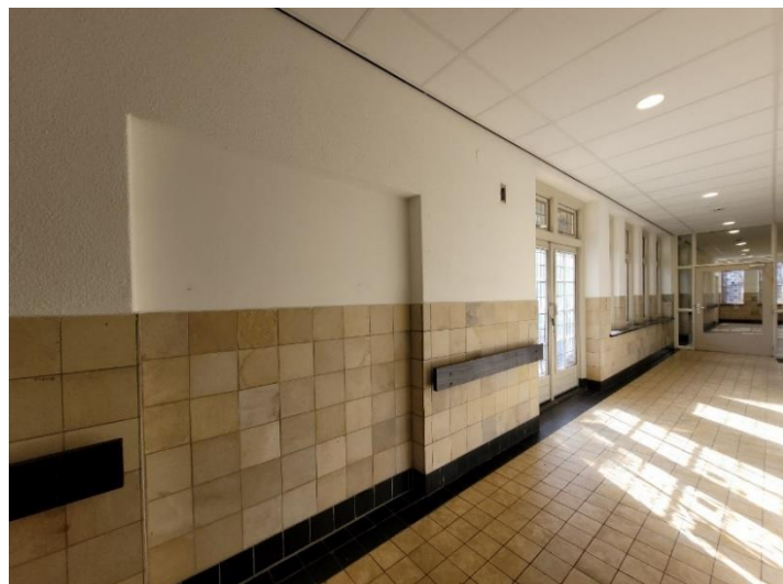
Omstreeks 2015 dichtgezette niet oorspronkelijke doorgang naar het eerste vertrek in de linker zijvleugel. Hierbij zijn dezelfde wandtegels als van de lambrisering toegepast.
