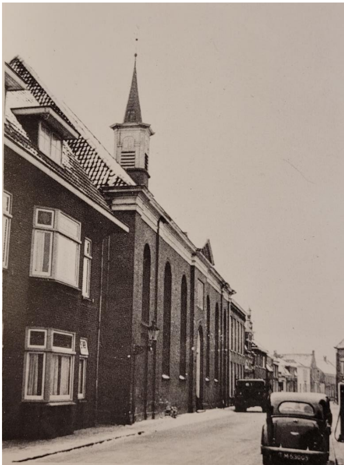
Het onderzochte gebouw in de periode tussen 1938 en 1954. De ramen van de dakkapellen met overstek hebben een roedenverdeling. De ramen in de voorgevel lijken wit te zijn geschilderd en de kozijnen in een afwijkende kleur.
