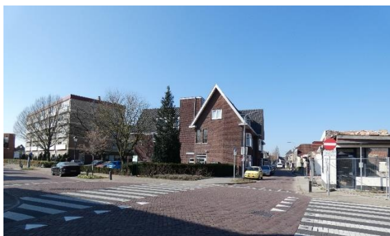
Het onderzochte gebouw op de kruising van de Holkerstraat en de Torenstraat.
