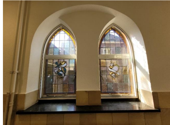
Gietijzeren spitsboogvensters met glas-in-lood en draaibare onderramen met hang- en sluitwerk uit 1938.
