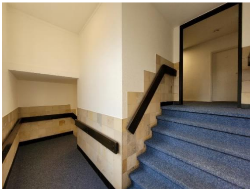
Het tweede tussenbordes van het trappenhuis.
