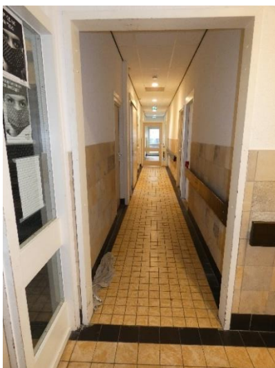
Open doorgang vanuit de gang in de hoofdvleugel naar de linker zijvleugel (ruimte 0.9). In de linker zijvleugel is een kleiner formaat tegel toegepast (10 x 10 cm).
