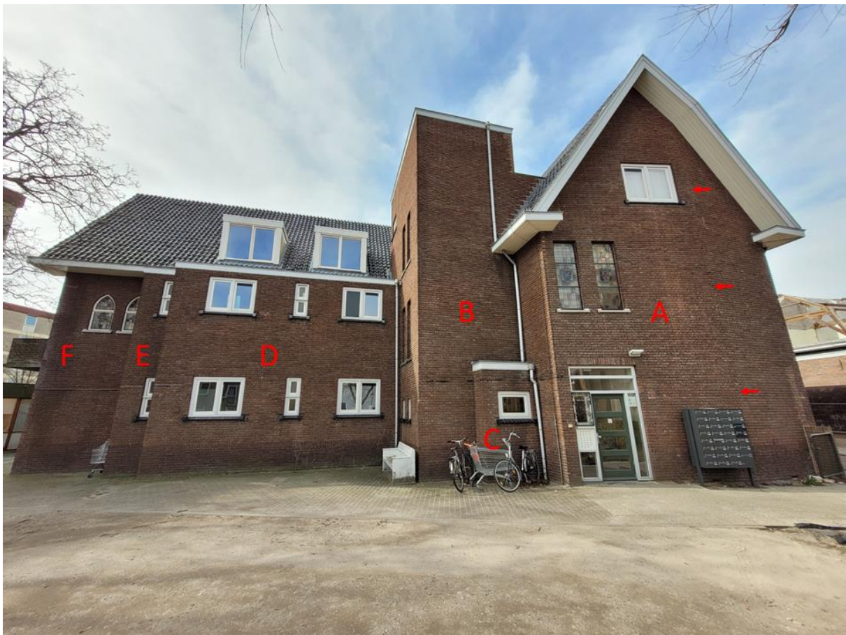
De linker zijgevel. De letters van de verschillende bouwdelen komen terug in de tekst. Ter hoogte van de rode pijlen maakt de topgevel (A) een knik.
