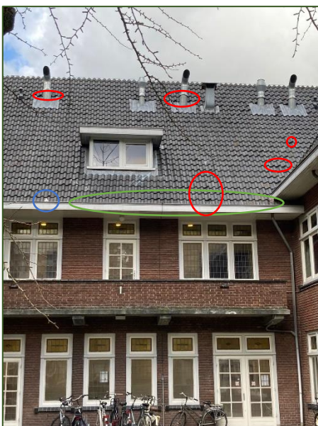
Fig. 2.4 Duivenpinnen op dakgoot, kieren tussen dakpannen, stadsduif zusterhuis (Bron: FF Solutions)
