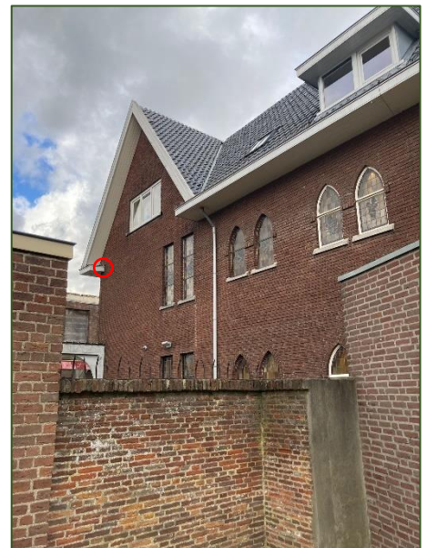
Fig. 2.6 Kieren rond boeidelen zusterhuis (Bron: FF Solutions)
