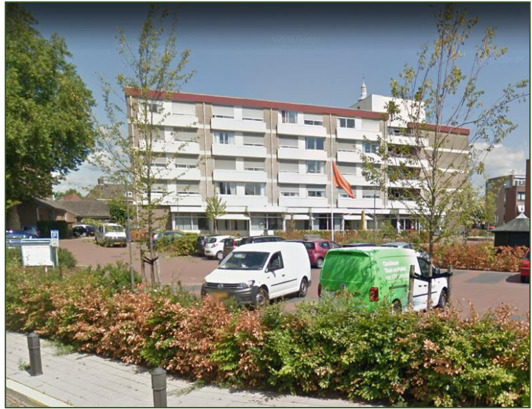
Fig. 2.3 Vooraanzicht woonzorgcentrum (bron: Google streetview 2017)
