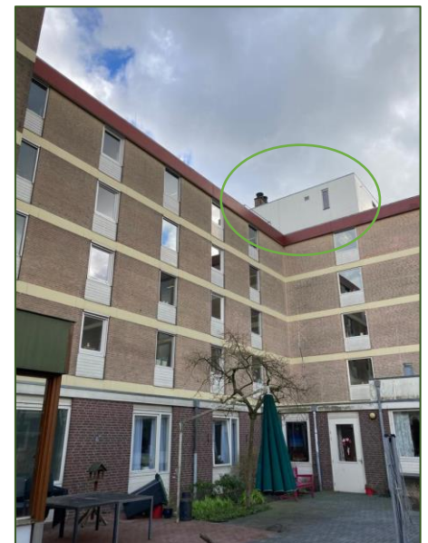
Fig. 2.12 Woonzorgcentrum noordzijde, houten CV hok (Bron: FF Solutions)
