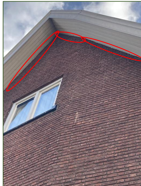
Fig. 2.8 Kieren rond boeidelen zusterhuis (Bron: FF Solutions)
