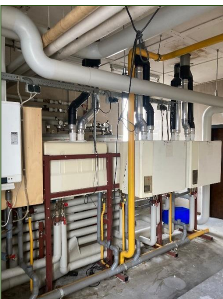
Fig. 2.13 Cv hok op dak woonzorgcentrum (Bron: FF Solutions)
