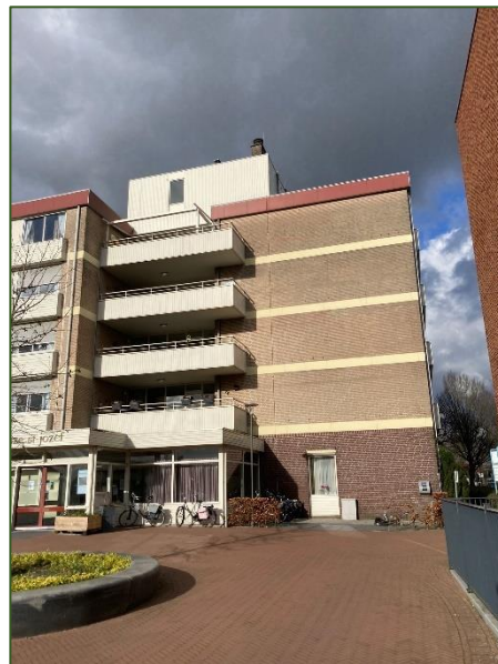
Fig. 2.11 Woonzorgcentrum zuidzijde (Bron: FF Solutions)
