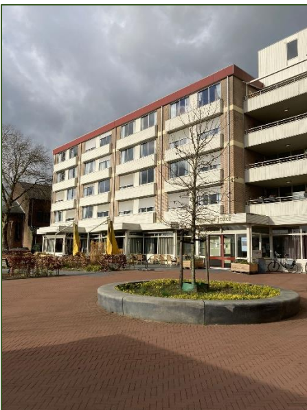
Fig. 2.10 Woonzorgcentrum zuidzijde (Bron: FF Solutions)
