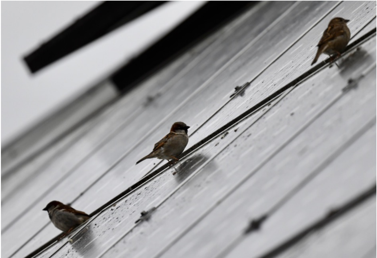
Foto 1 | Zonnepanelen op de zuidzijde van het dak van de jongveeschuur met enkele hier nestelende huismussen.
