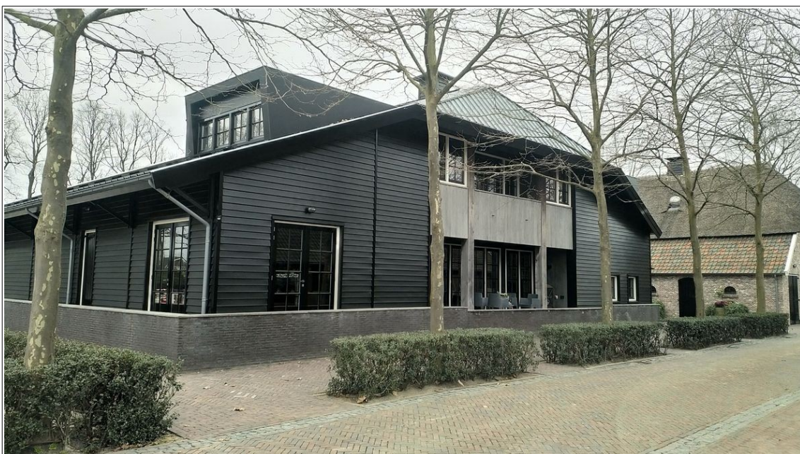
Zuidgevel van de binnenbak welke onderdeel uitmaakt van de de paardenstal gezien vanuit het zuiden. Foto: M de Vries | Ecoresult B.V.
