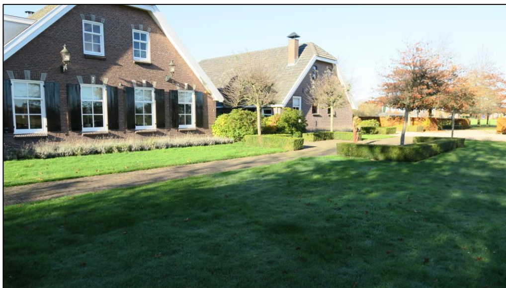
Figuur 1 In de boerderij op de planlocatie worden dakvensters gerealiseerd.
