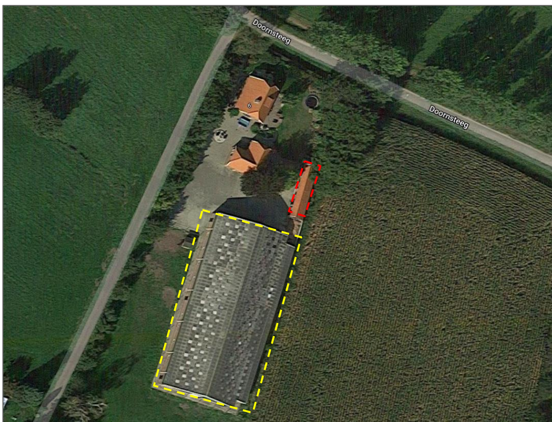
Figuur 2.2. Opstallen te Doornsteeg 6. De rode stippellijn geeft het pand weer dat bij de voorgenomen werkzaamheden worden gesloopt. De grote paardenstal (geel omlijnd) is reeds door derden gesloopt, maar maakt wel onderdeel uit van de ontheffingsaanvraag.
