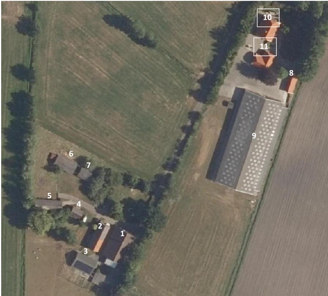
Figuur 3.2 Overzicht van de opstallen op de percelen van Doornsteeg 6 en Doornsteeg 8. De omkaderde cijfers (10 en 11) geven de panden weer die bij voorgenomen werkzaamheden niet worden gesloopt.
