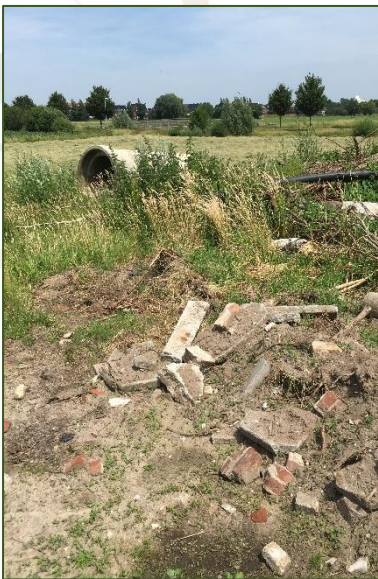
Steenhopen binnen projectlocatie (Bron: FF Solutions)
