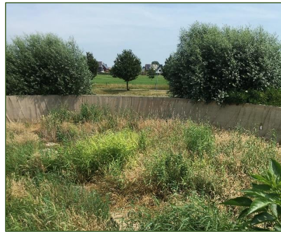
Fig. 0.4 Ronde mestopslag met kruid laag (bron: FF Solutions)
