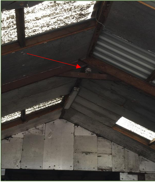
Postduif op balk in schuur buiten projectlocatie (Bron: FF Solutions)
